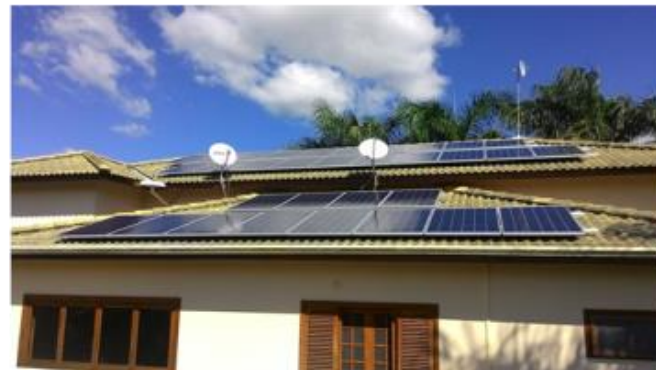
Estruturas p/ Telhado
