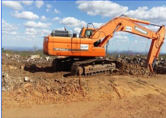
• Escavação de Fundação
