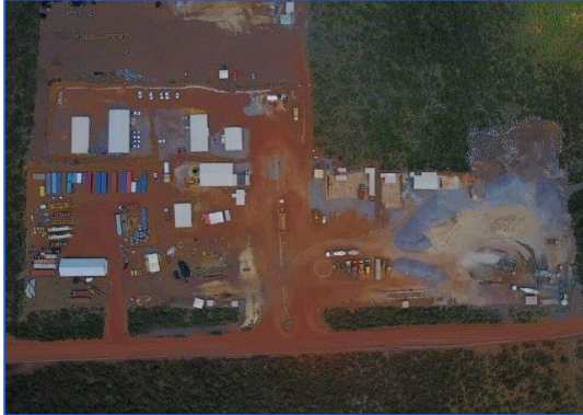
• Canteiro de Obras
