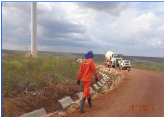
• Execução de Valetas
