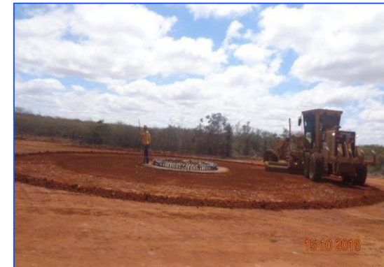
• Aterro de Fundação
