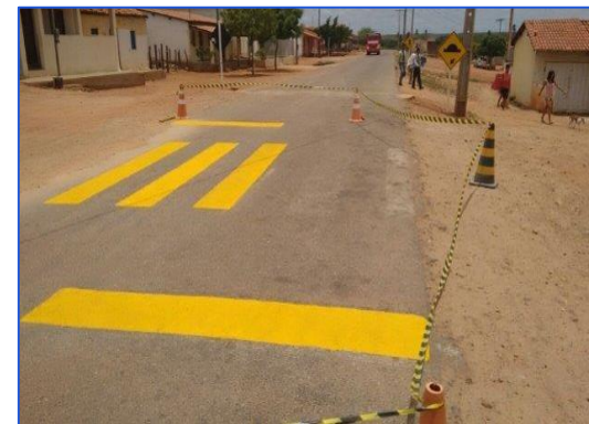
• Acesso Externo - Sinalização
