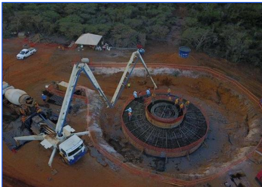
• Concretagem de Fundação
