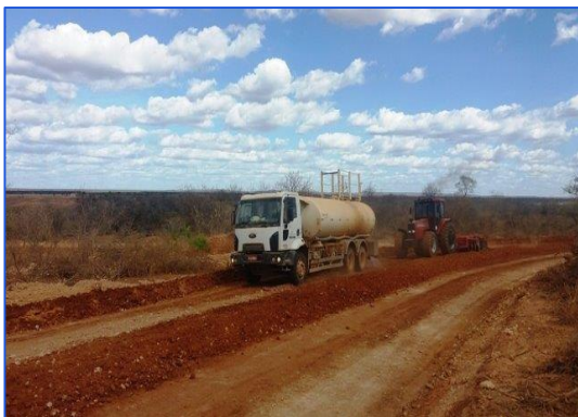
• Acesso Externo - Terraplenagem
