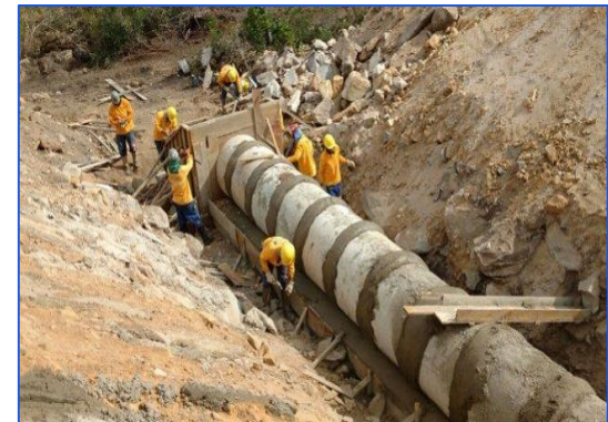
• Finalização do Berço da Conduto
