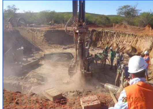
• Perfuração de Estacas
