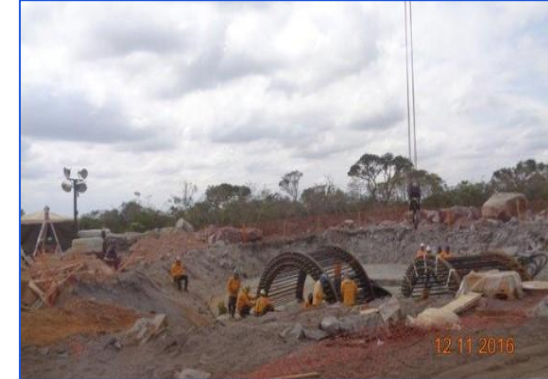
• Montagem de Anchor Cage
