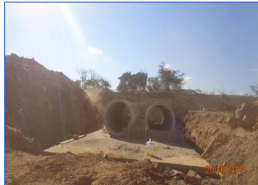
• Execução de Bueiros
